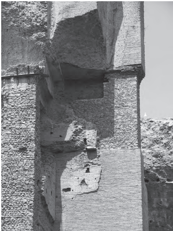
1: Frigidarium, Südwestecke mit Abdruck der Gebälkblöcke der monumentalen Säulenordnung
