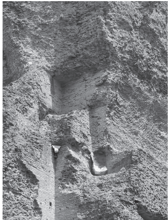
2: Frigidarium, Nordwestecke mit Abdruck der Gebälkblöcke, Rest des Auflagerblocks und Abakusecke in situ
