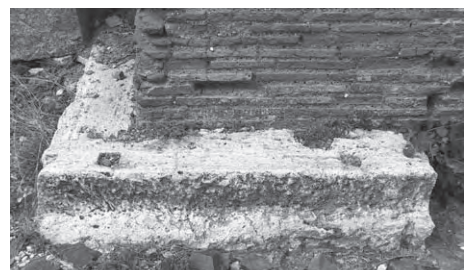
4: Frigidarium, Durchgang zur Natatio, Westseite, Fundament der umlaufenden Pilasterbasis
