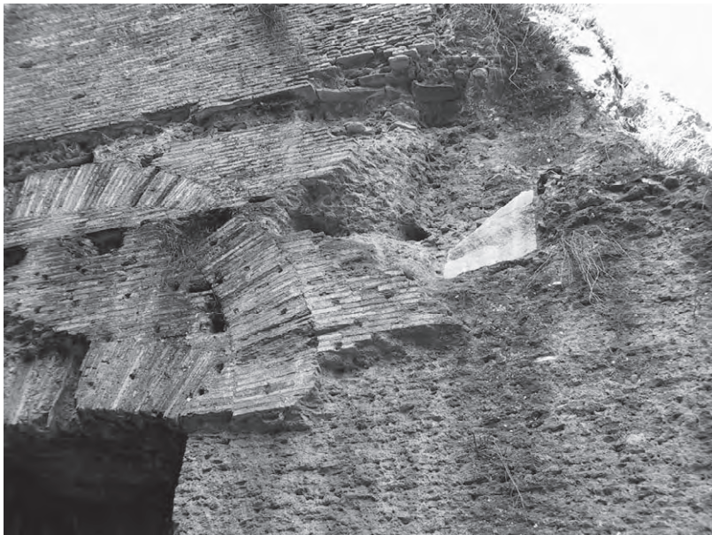
3: Westliche 'Palästra', Wand zu Raum 11 mit Rest des Kapitellblocks und Abdruck des Architrav-Fries-Blockes im Gußmauerwerk
