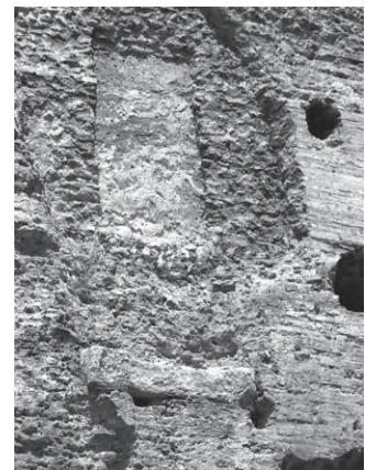
4: Westliche 'Palästra', Wand zu Raum 7 mit Travertinplatte als Auflager für den Kapitellblock und Abdruck des Architrav-Fries-Blockes im Gußmauerwerk
