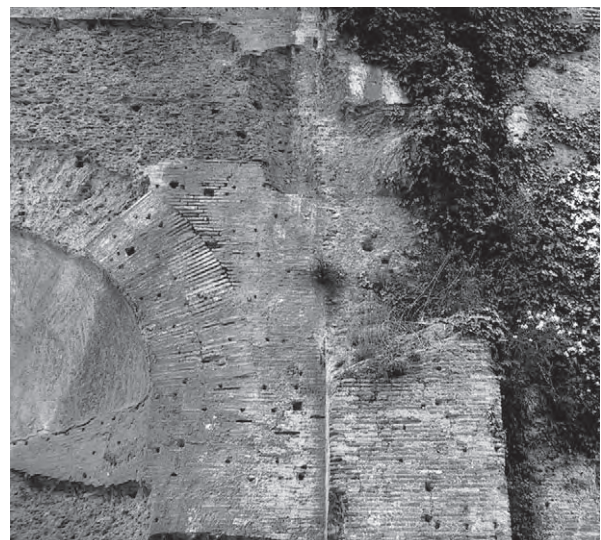
3: Frigidarium, Durchgang zur Natatio, Westseite, mit Abdruck der Gebälkblöcke
