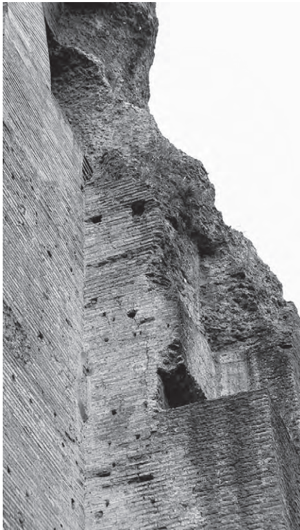
2: Natatio, Südwestecke mit Abdruck der Gebälkblöcke der Säulenstellung vor Raum 1
