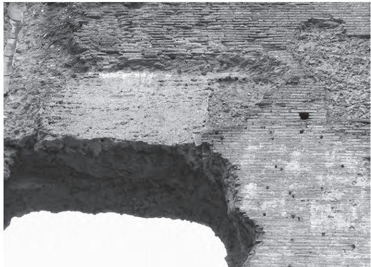
1: Natatio, Nordwestecke mit Abdruck des Gesimsblockes der monumentalen Säulenordnung
