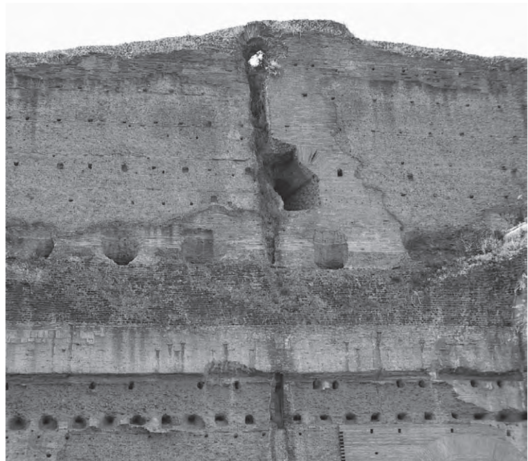
2: Westliche 'Palästra', Südwand mit Gewölberest der Porticus und den großen Löchern für die Ankersteine unter dem Terrassenniveau; unten die ausgeraubten Klammerlöcher für den Wandarchitrav und -fries
