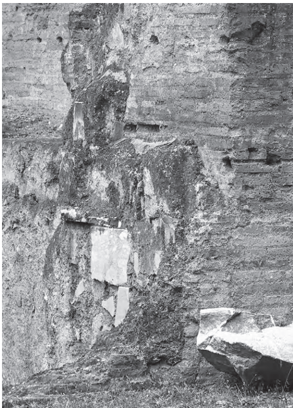
3: Frigidarium, südwestliches Becken, Westflanke mit schmalen Mauersockel und Abdruck der Pilasterbasis darüber
